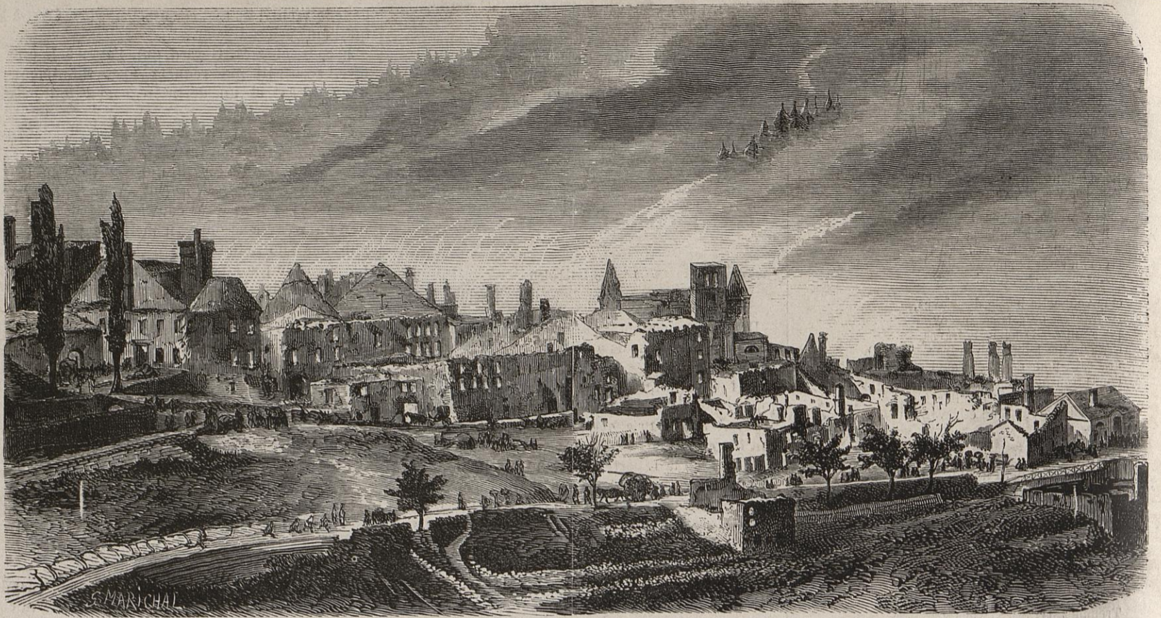
Jougnes (Doubs), frontière suisse, au moment de l'incendie qui l'a complètement détruit. — Vue prise du côté de la France.
