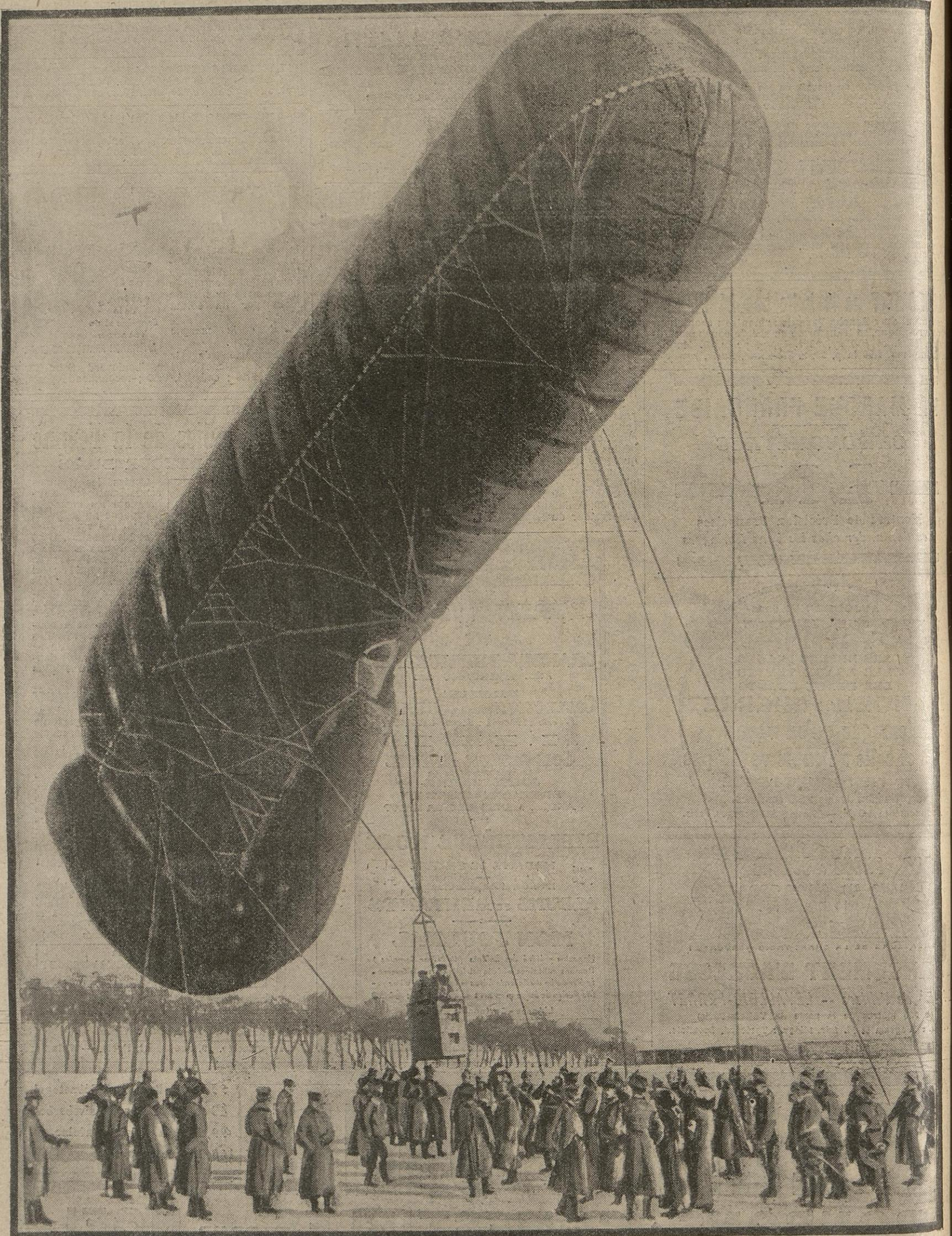
Ce système de ballon captif que nos soldats appellent « la Saucisse » est employé dans l'armée allemande. Il sert de poste d'observation et est surtout utilisé par grand vent. Grâce à un dispositif spécial, ce ballon, même lorsqu'il est pris dans des rafales, ne se meut que très lentement et permet à l'observateur d'exécuter des reconnaissances sans le moindre danger.
