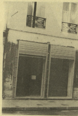
Façade inachevée de la rue Amelot
