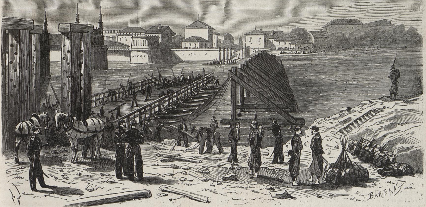
Suppression du pont de bateaux sur le Rhin entre Kehl et la frontière française. (D'après les croquis de notre correspondant, M. R. Dapré.)
