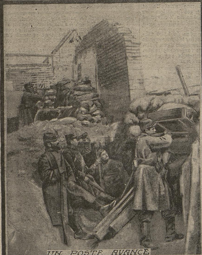
UN POSTE AVANCE
