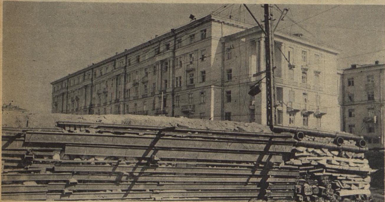
VOICI UNE MAISON FORTIFIÉE, PROTÉGÉE PAR UN REMPART DE PIERRES, DE RAILS, DE TUYAUX, DESTINÉE À FAIRE ÉCHEC AUX CHARS.
