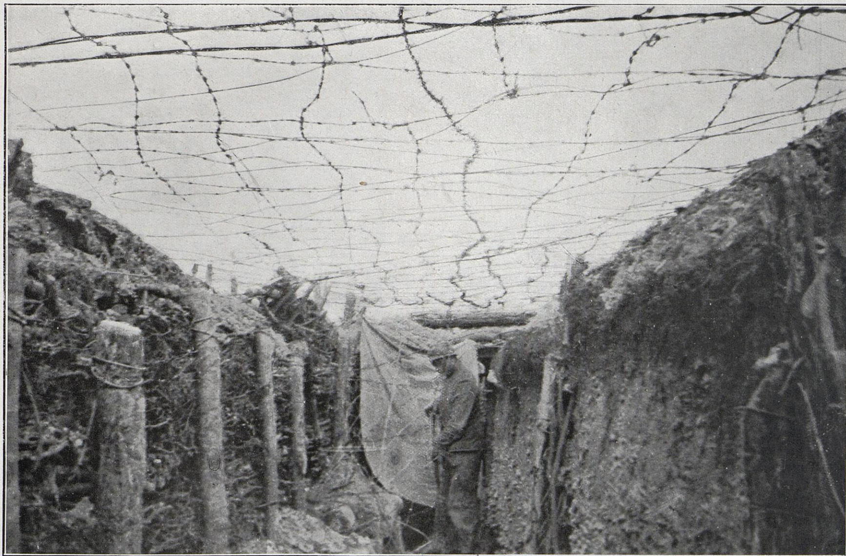
LA PLUS RÉCENTE TROUVAILLE. — C'est la tranchée prémunie contre la chute des grenades. Le fil de fer que l'on emploie beaucoup au front joue ici le rôle de toit protecteur. Nos soldats disent en riant : « Confort et sécurité ! »
