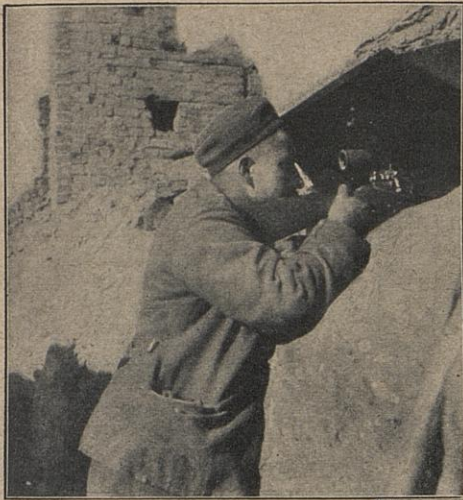
Sorch-Posten mit Zielfernrohr-Gewehr in einer vorgeschobenen Stellung an der Bzura in Russ.-Polen.
