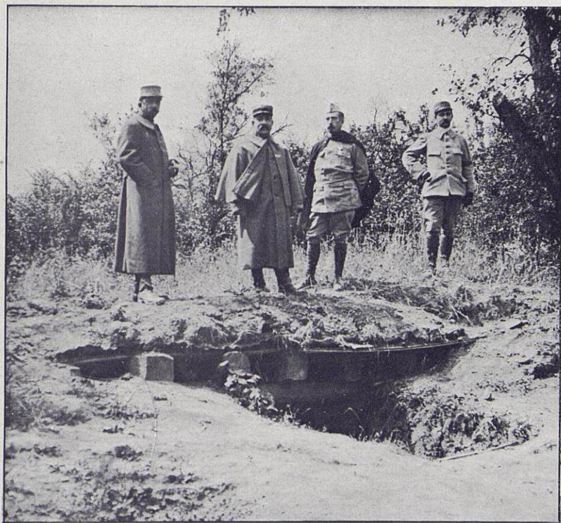
Cette excavation a servi, au mois de septembre dernier, d'entrée au fameux terrier du kronprinz. Nos sapeurs l'ont utilement exploitée.
