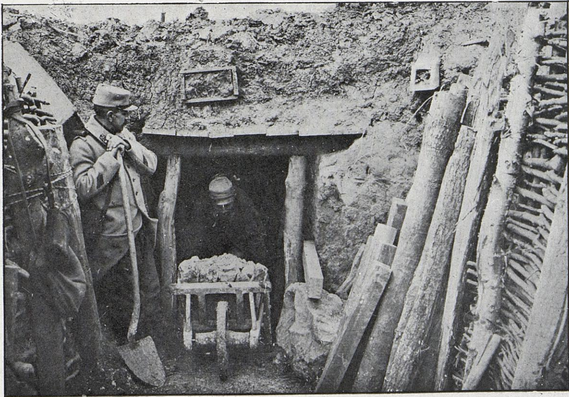
Entrée d'une sape. Pour déblayer la terre, on doit parfois utiliser un petit chariot qui se meut au moyen d'un câble, l'étroitesse de la galerie ne permettant pas le passage d'une brouette.
