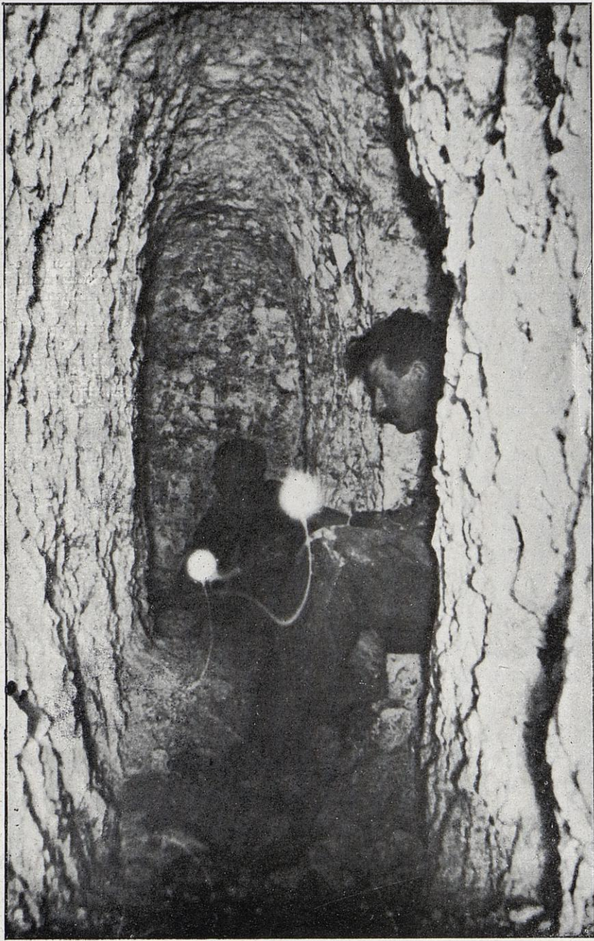
Sapeurs travaillant à la lumière électrique, dans un sape en voie d'achèvement dans la Meuse.
