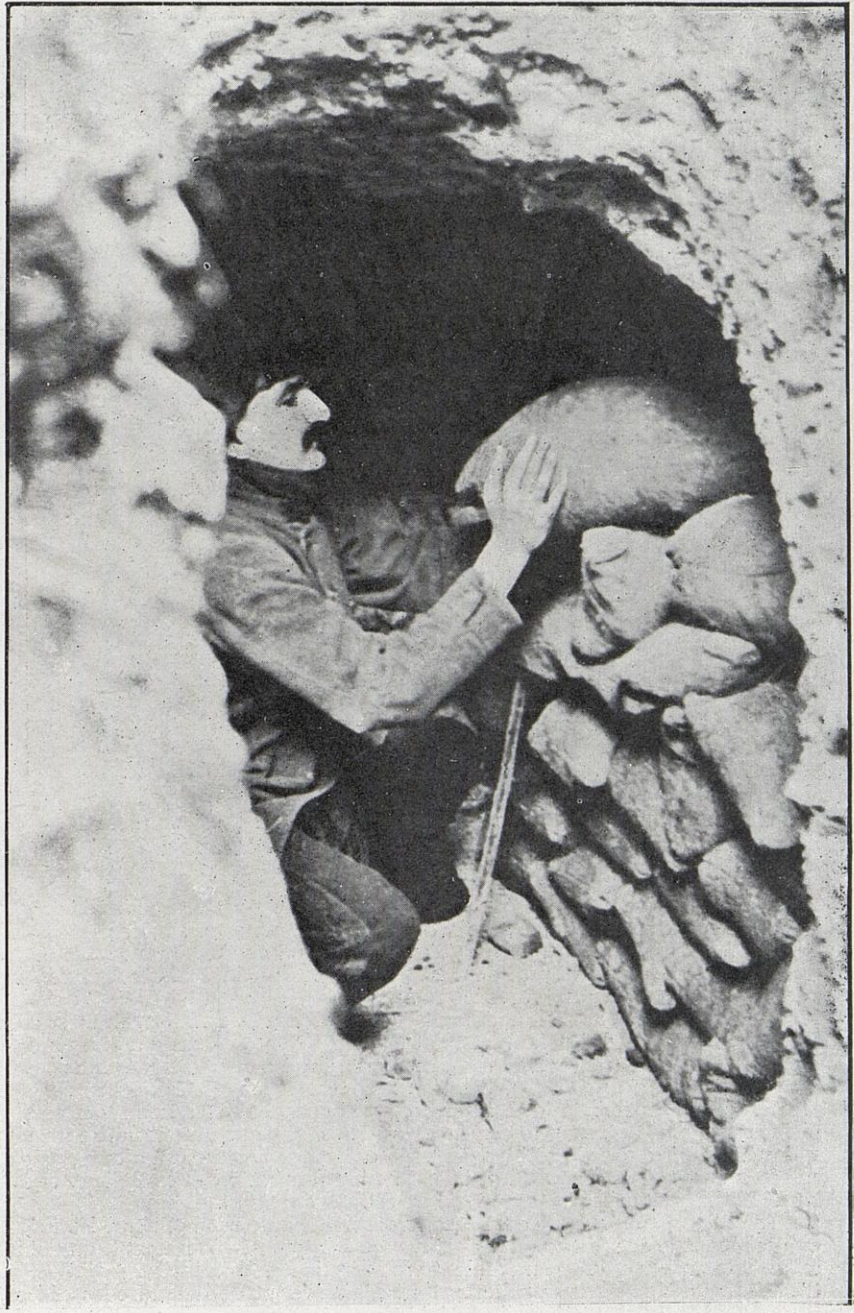
On s'est aperçu de l'avance des travaux de l'ennemi. Quelques sacs de terre empêcheront l'éboulement de notre galerie parallèle.
