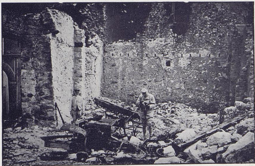
Dans la cour intérieure, les restes de l'automobile qui attendait les maîtres du logis pour les emmener, et qui fut calcinée sur place.
