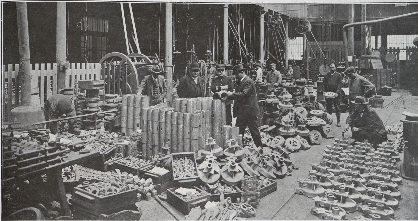
Contrôle et recette de pièces diverses en bronze pour matériel de 105 et 155 Schneider.
