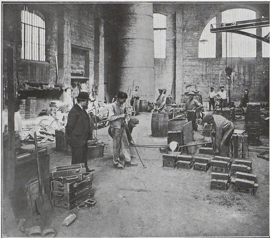
Fonderie d'acier au creuset et fours à huile lourde. Coulée des pièces moyennes pour matériel de 105 et 155 Schneider.
