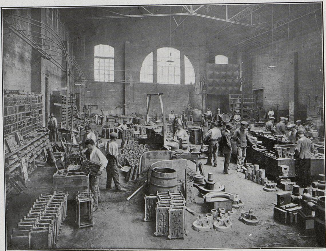
Noyautage des pièces moyennes en bronze, pour matériel de 105 et 155 Schneider.
