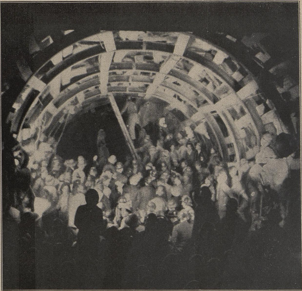
Ein feierlicher Moment mitten in schwerer Arbeit: Der letzte Felsbrocken ist gefallen, Wasser für Kalifornien kann durch diesen Tunnel strömen...
