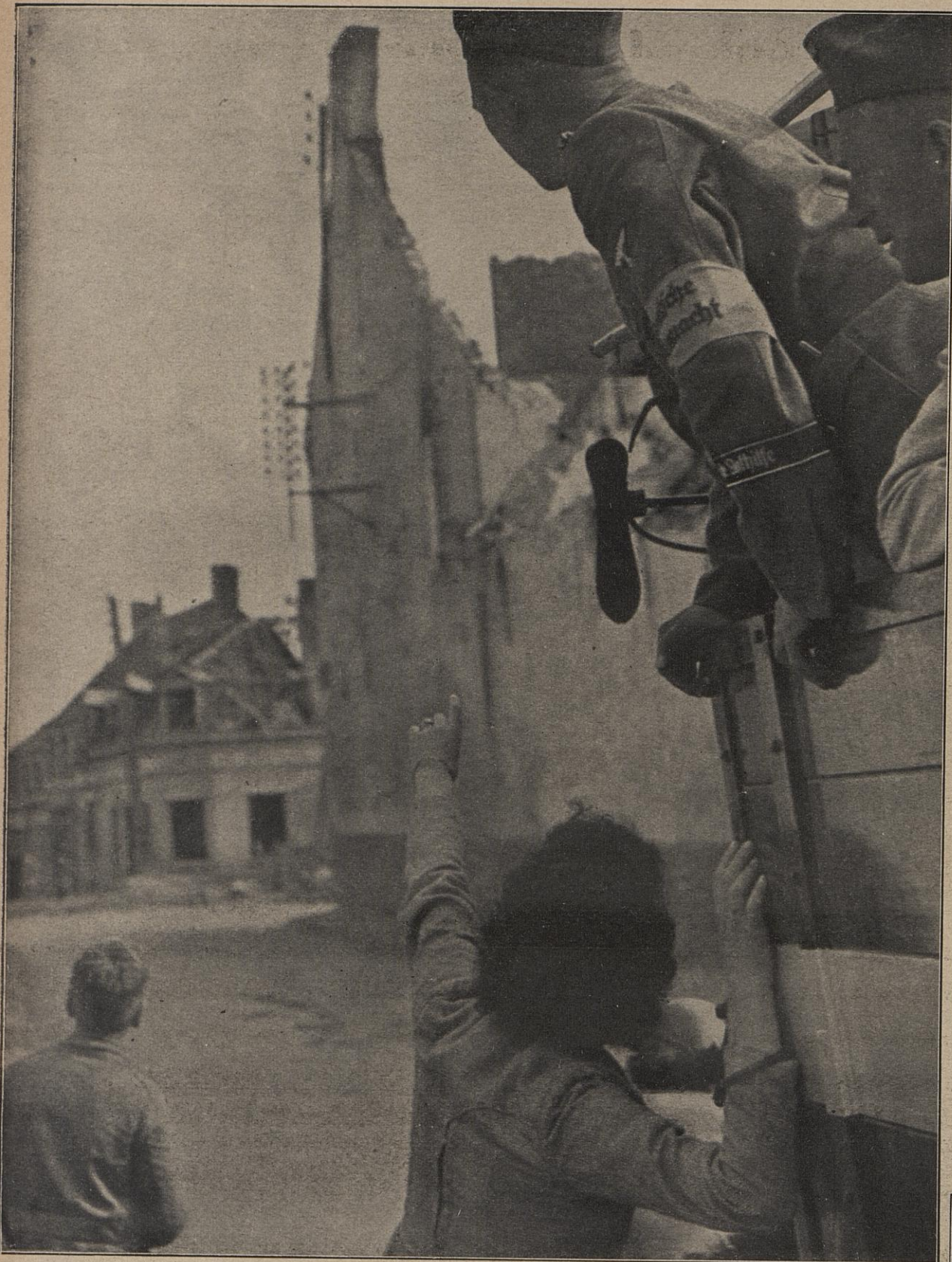
Diese Giebelwand bedroht die Straße.
