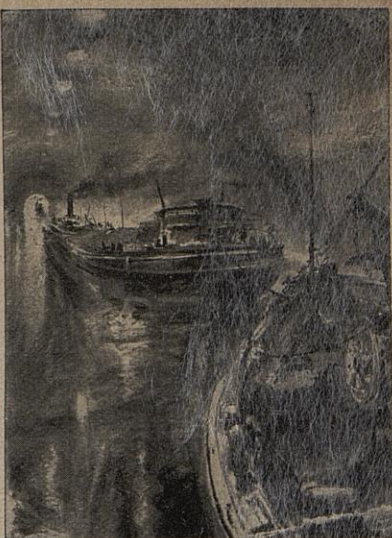
Unter dem Burgberg von Schloß Laufen: Der 12 Meter breite Schiffstunnel. In ihm können Schiffe bis zu 1500 Tonnen Inhalt fahren.
