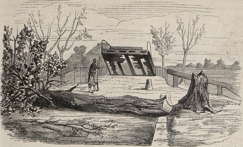
Destruction du pont du canal de l'Ourcq, à Bondy.
