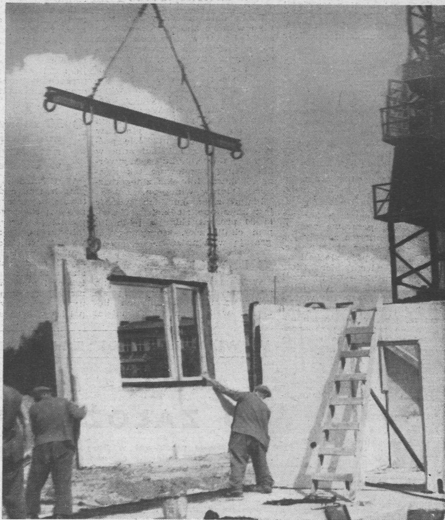
Budowa domu z płyt prefabrykowanych.
