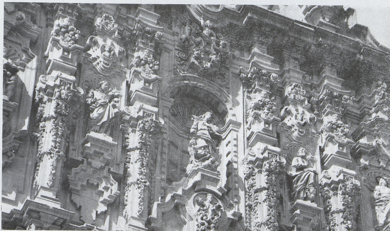
Façade de la Chapelle paroissiale. Détail.
