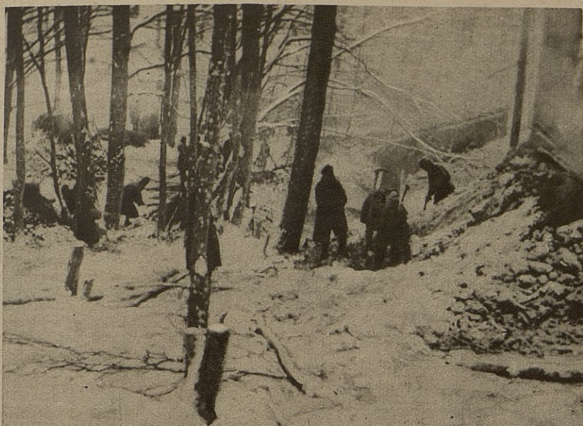
Pionniers roumains travaillant, malgré un froid intense, à la construction d'abris dans un bois. Pendant que les uns creusent la terre profondément gelée, d'autres coupent des arbres dont ils se serviront pour consolider et défilé les installations projetées.
