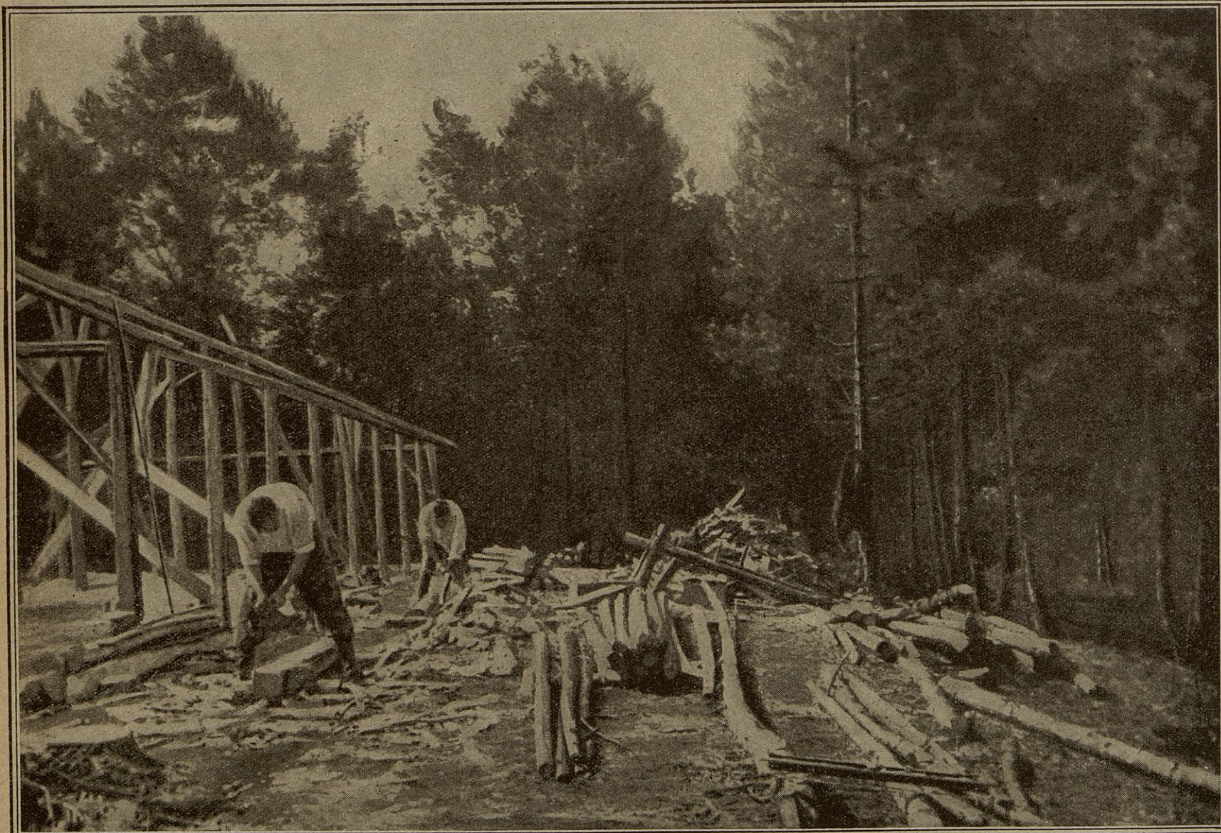
Ces briques serviront à former les murs des baraquements en construction ; on voit ici des soldats-charpentiers équarrir les troncs des sapins qu'ils viennent de couper et élever les cloisons que boucheront les briques faites par les camarades. Bientôt surgira un cantonnement entièrement construit par nos poilus.
