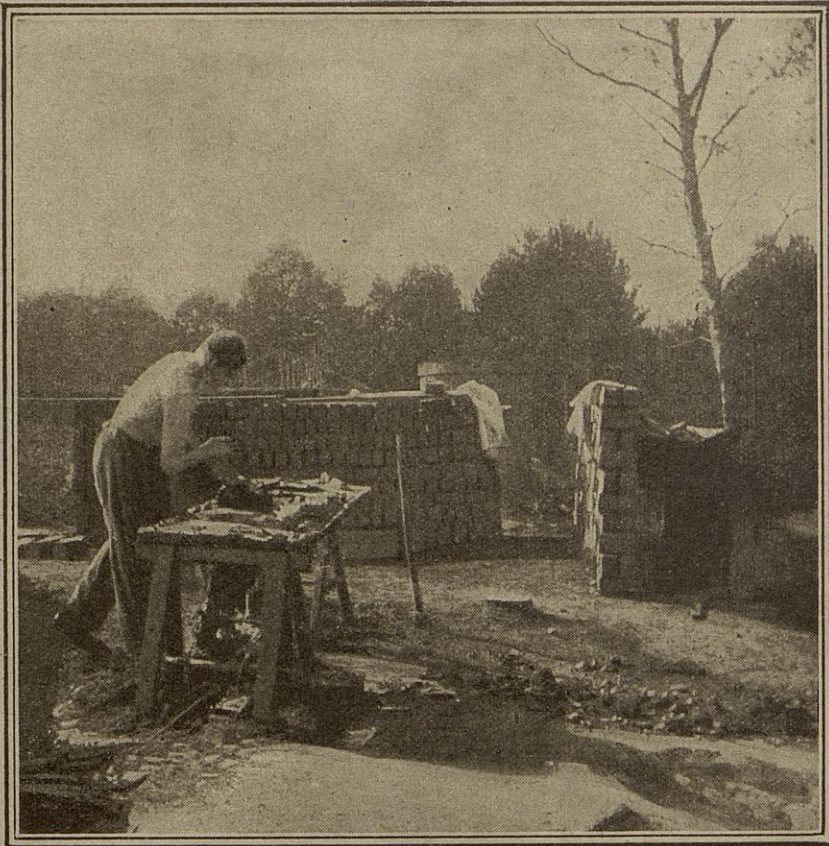
Après avoir été convenablement broyée et pétrie, l'argile est façonnée en briques ; sur un établi de fortune, un soldat lui donne la forme voulue. Puis un four improvisé assurera la cuisson de ces matériaux solides et légers.
