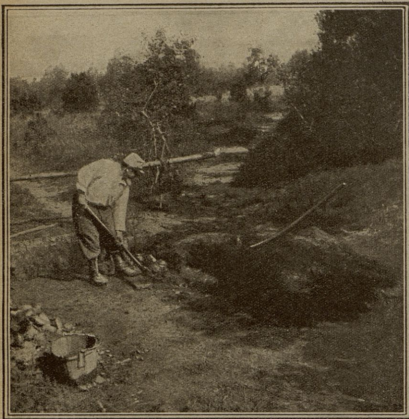
Aux divers métiers que la guerre a imposés à nos soldats et que nous avons déjà représentés il convient d'ajouter celui de brique- tier. Voici un brave poilu qui creuse le sol pour enlever l'argile nécessaire à la fabrication des briques.
