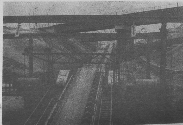
Skrzyżowanie tras przenośników taśmowych z torami kolejowymi na terenie kopalni odkrywkowej
