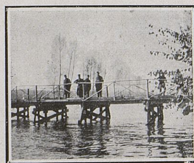
PONT A CHEVALETS improvisé par le génie, sur la Meuse.
